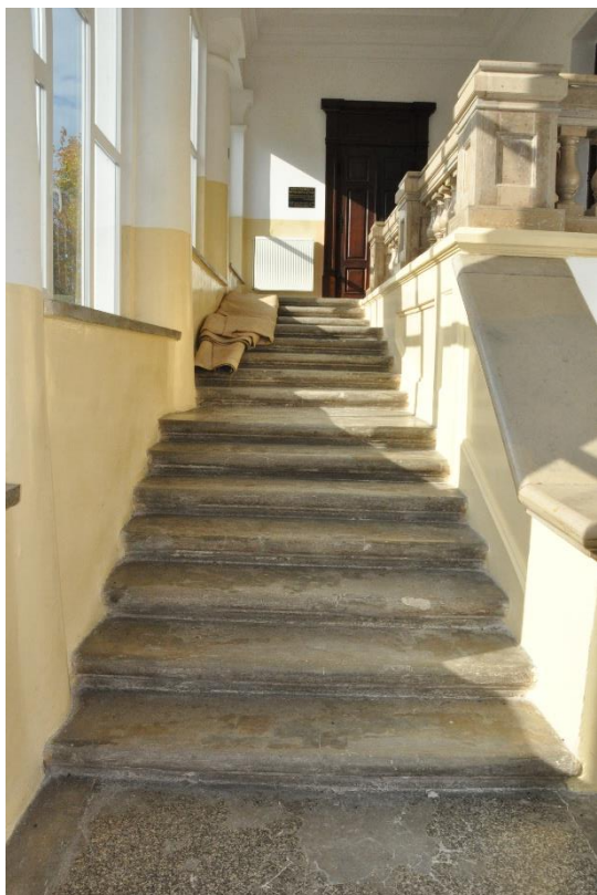
Pałac Kołłątajów w Wiśniowej przed remontem
