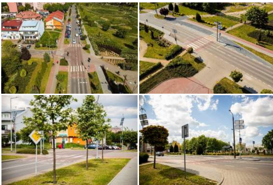
Foto 17. Przebudowane przejścia dla pieszych na ulicy Mickiewicza w Staszowie.
