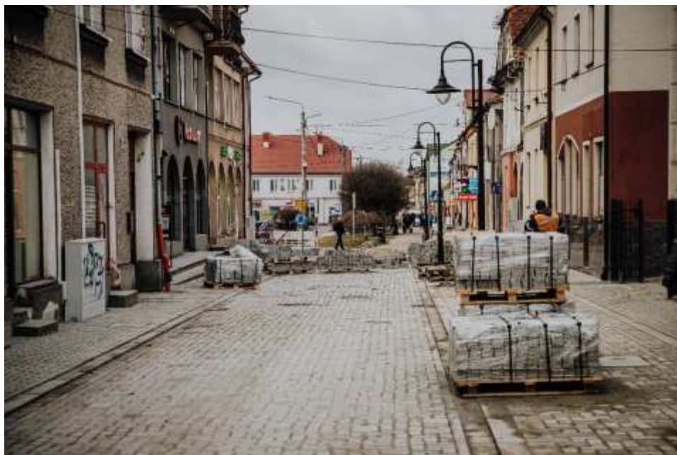
Foto 20. Ulica Kościelna w Staszowie, w trakcie prac modernizacyjnych.
