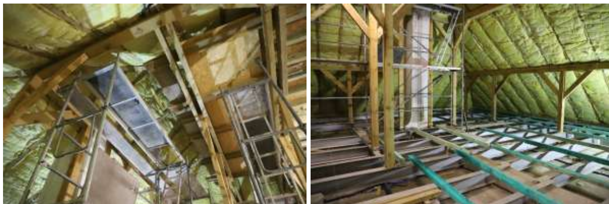
Foto 19. Zdjęcia wykonywanych prac remontowych w Ratuszu.
