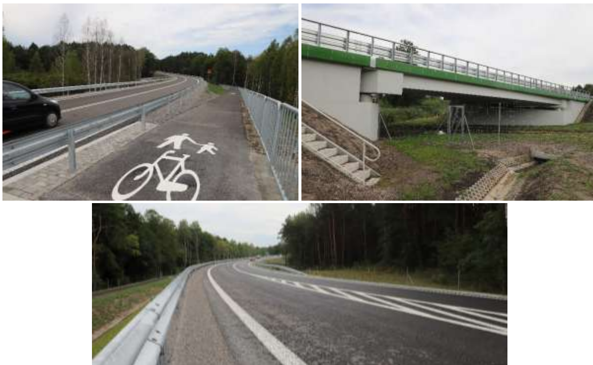
Foto 24. Nowy odcinek obwodnicy Staszowa.
