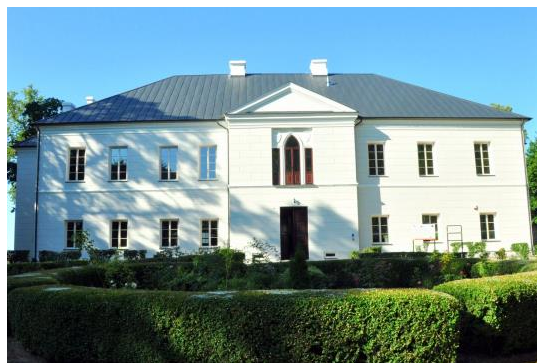
Pałac H. Kołątaja po przeprowadzonej termomodernizacji
