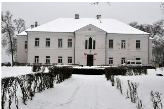
Pałac H. Kołątaja stan przed termomodernizacją
